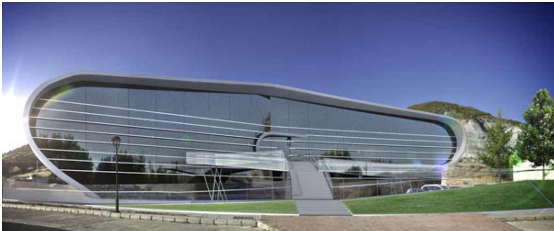
Centro de la Construcción Sostenible ubicado en el municipio de Padul
